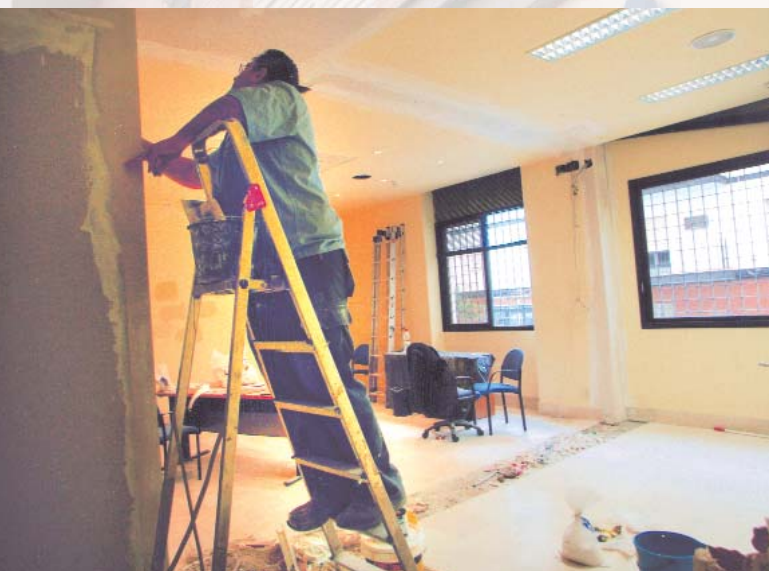
Obras de mejora
