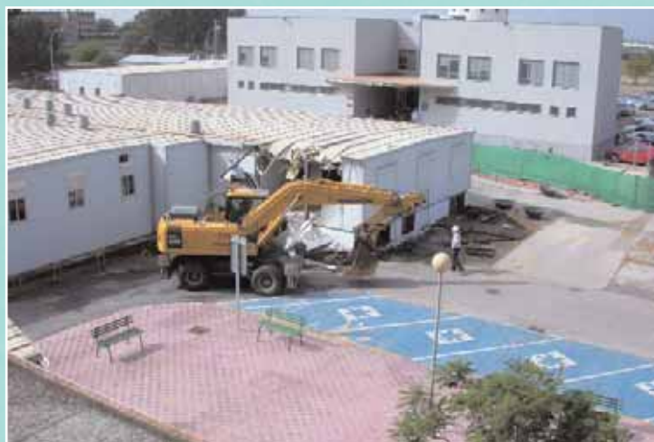
Inicio de las obras
